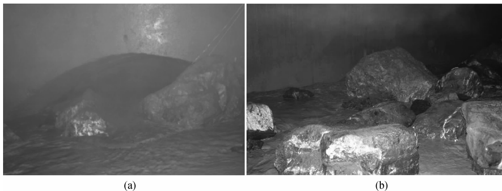
图 11 宜万线野三关隧道突水
